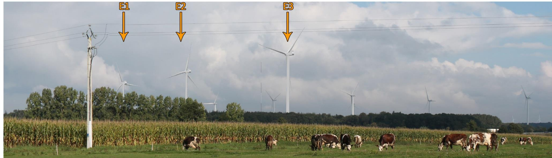
Les éoliennes supplémentaires densifient le parc existant sans perturber la géométrie perçue.
